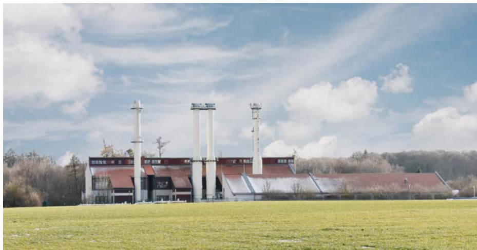
Gasverdichterstation der terranets bw in Dornstadt-Scharenstetten nahe Ulm
