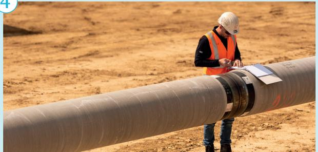
Die Schweißnähte werden sorgfältig von einem unabhängigen Sachverständigen geprüft und freigegeben.
