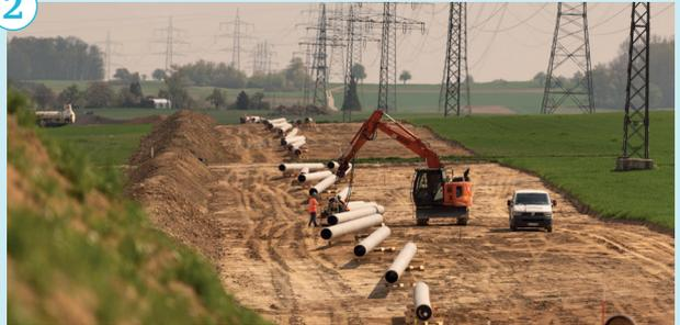
Die Leitungsrohre werden auf der vorbereiteten Trasse ausgelegt.
