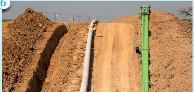
Eine besondere Herausforderung ist die Verlegung der Leitungsrohre in steilem Gelände.
