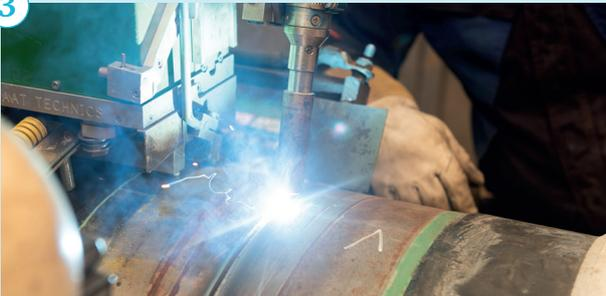
Anschließend werden die Rohre zu einem langen Strang verschweißt.
