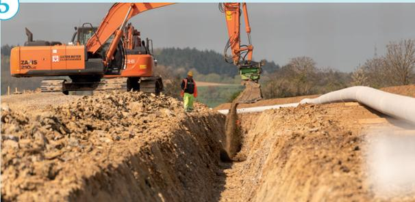
Nun wird der Rohrgraben ausgehoben – rechts die bereits zu einem Rohrstrang verbundenen Leitungsrohre.
