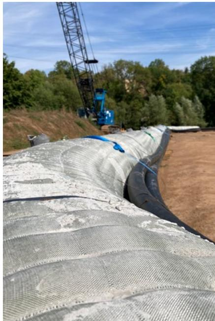
So einfach wie genial: Eine Hülle aus Kunststoff und Beton schützt den Düker vor Beschädigungen und verhindert den Auftrieb im Wasser
