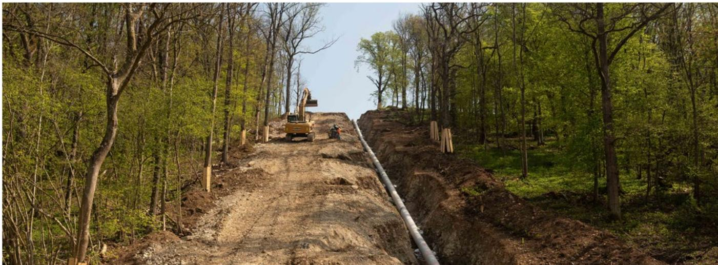
Auch die Verlegung einer Gashochdruckleitung in steilem Gelände wird als Sonderbaustelle durchgeführt
