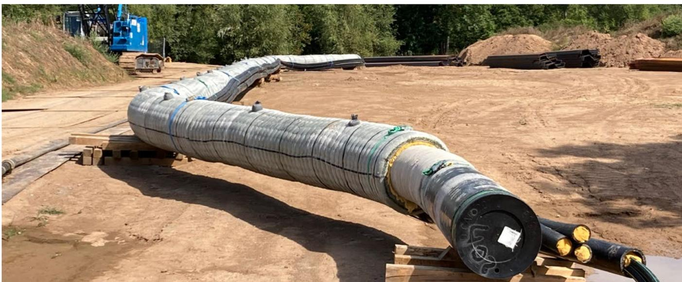
Der an Land vorbereitete Düker mit Betonmantel wartet auf den Einbau in die Enz
