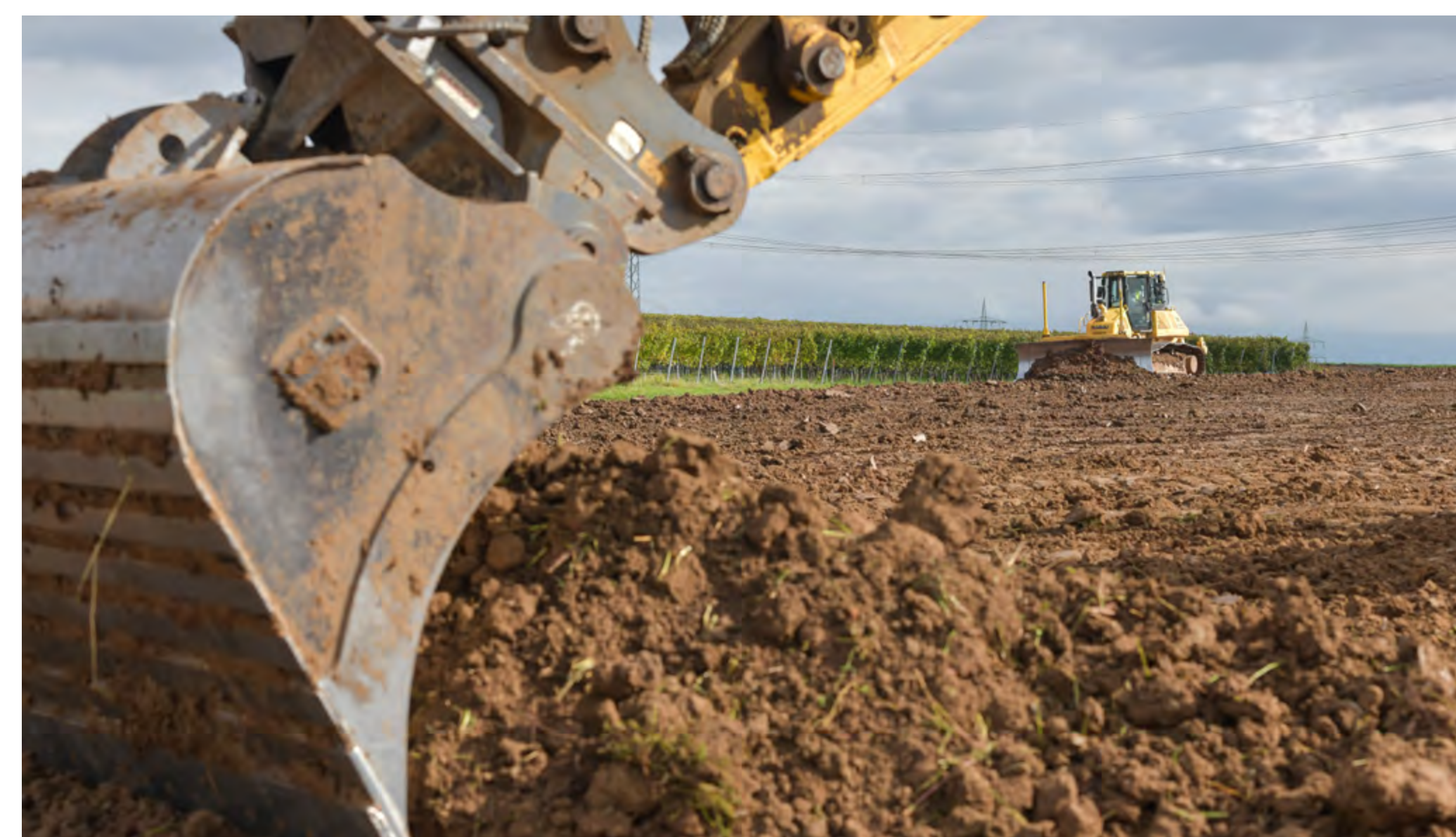
Fachgerechte Lagerung des Bodens, indem der Boden getrennt nach Oberboden (A-Horizont), Unterboden (B-Horizont) und Ausgangsgestein (C-Horizont) abgetragen und auf Mieten angehäuft wird
