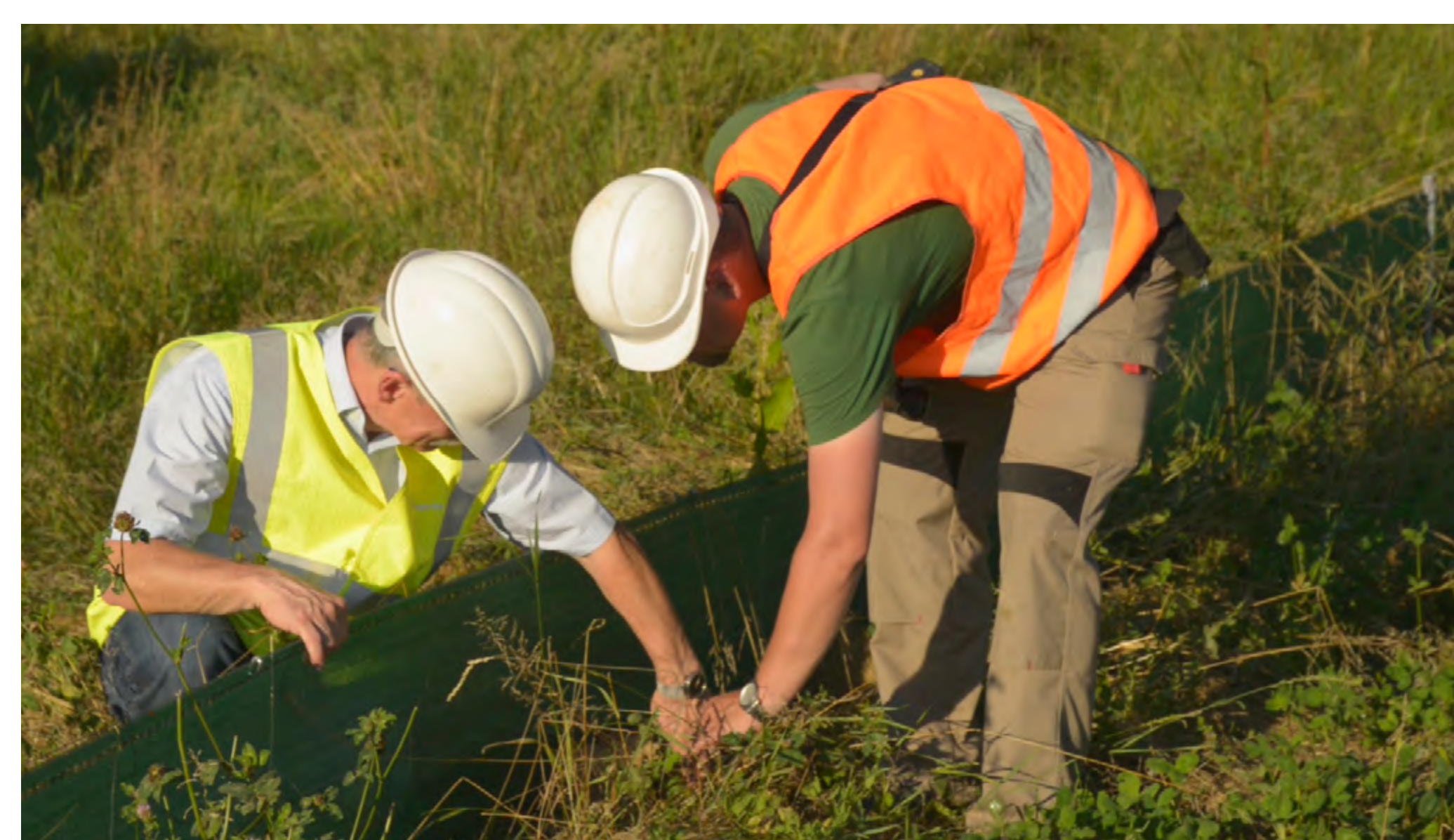
Anlegen von Baustraßen und Schutzzäunen zum Schutz des Bodens, von Bäumen und Gehölzen sowie für Reptilien und Amphibien
